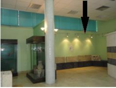
الصورة (١٢١): الإضاءة الصناعية الخارجية في صالة الفن الإسلامي: تظهر وحدات الإضاءة المعلقة على مجرى مثبت على الجدار، والموجهة بشكل مباشر إلى المعروضات، مع وجود مسافة كبيرة تشتت الضوء قبل وصوله للعنصر المعروض. المصدر: الباحثة.
