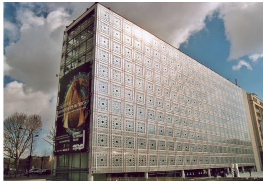
الصورة (٢) المركز الثقافي العربي في باريس - فرنسا، تصميم جان نوفيل: اعتمد في تصميم واجهاته على عناصر وفتحات مشابهة للمشربيات في العمارة العربية، تعمل كمرشحات للضوء وتتحكم بكمية الإضاءة التي تدخل المبنى، عبر الانفتاح والانغلاق تبعاً لشدة الضوء-المصدر: www.m3mare.com
