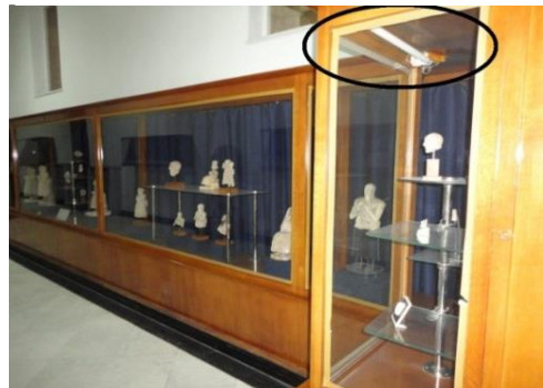
الصورة (٩٠): سوء تركيب مصباح الفلورسانت داخل خزنة العرض، مع عدم وجود أي فلاتر لحماية المعروضات-المصدر: الباحثة.
